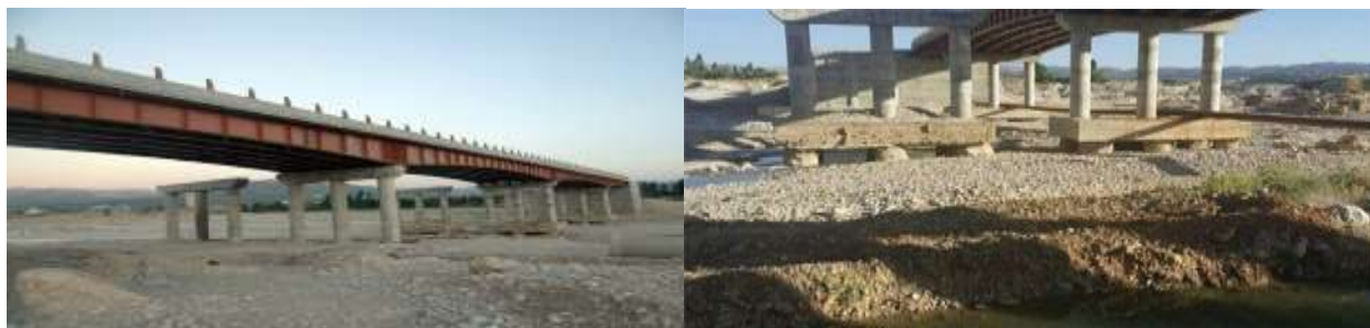
شکل ۳- تخریب پایه های پل بشار در اثر برداشت بی‌رویه ی شن و ماسه
