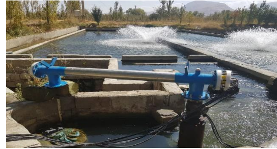
شکل ۱- دستگاه UV نصب شده (مجهز به چهار لامپ) روی دریچه خروجی آب کارگاه پرورش ماهی قزل آلاي رنگين کمان واقع در شهرستان کيار
