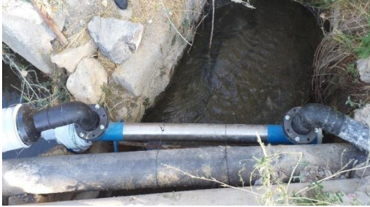
شکل ۱- دستگاه UV نصب شده (مجهز به چهار لامپ) روی دریچه خروجی آب کارگاه پرورش ماهی قزل آلاي رنگين کمان واقع در شهرستان کيار
